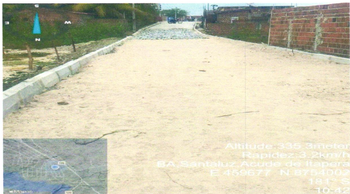
Execução de pavimentação Rua projetada 06
