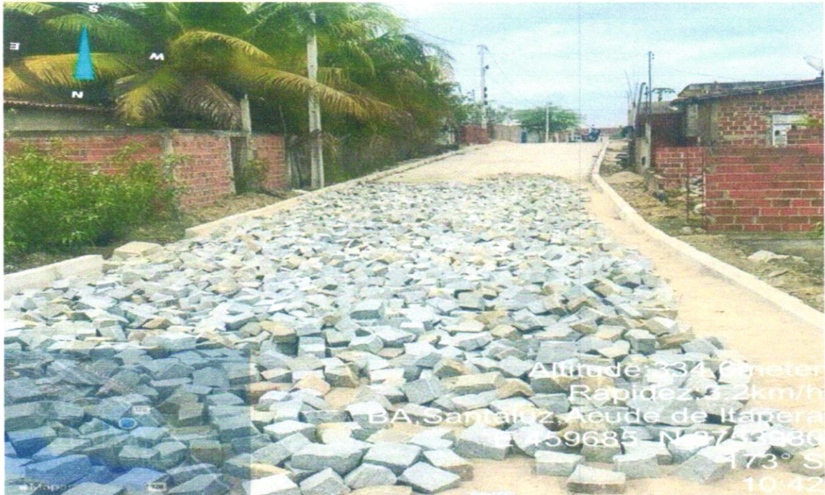
Execução de pavimentação Rua projetada 06
