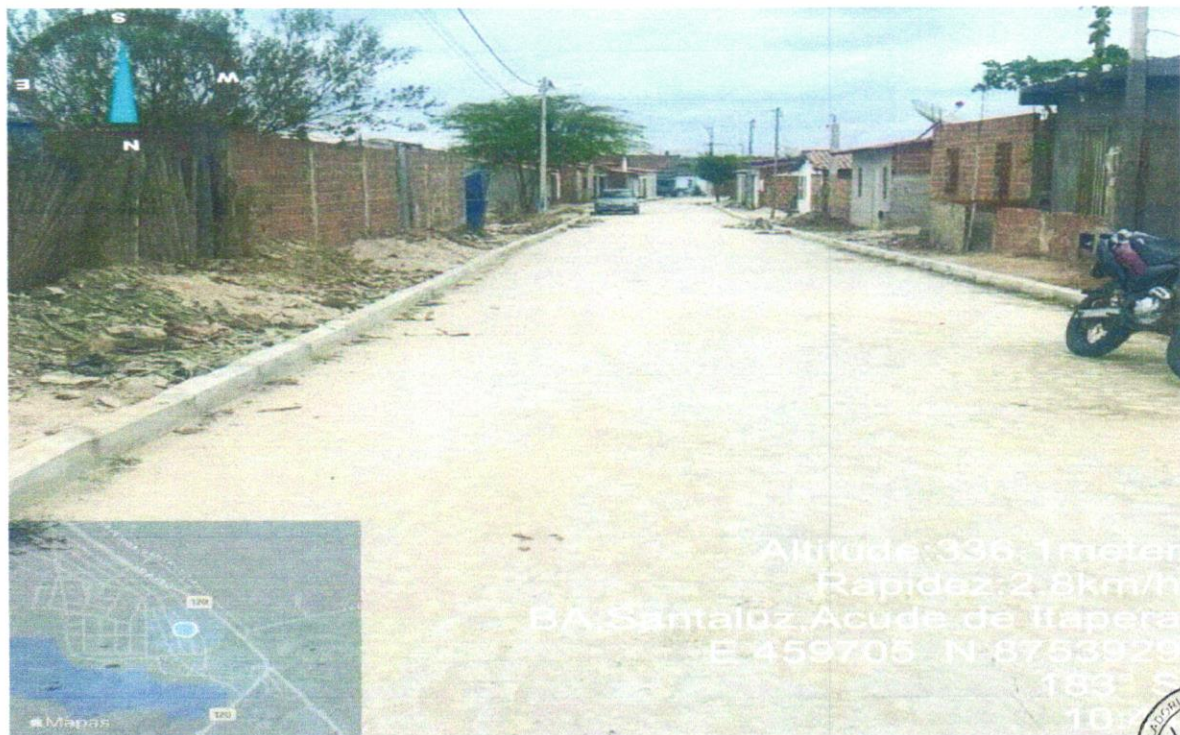
Execução de pavimentação Rua projetada 06
