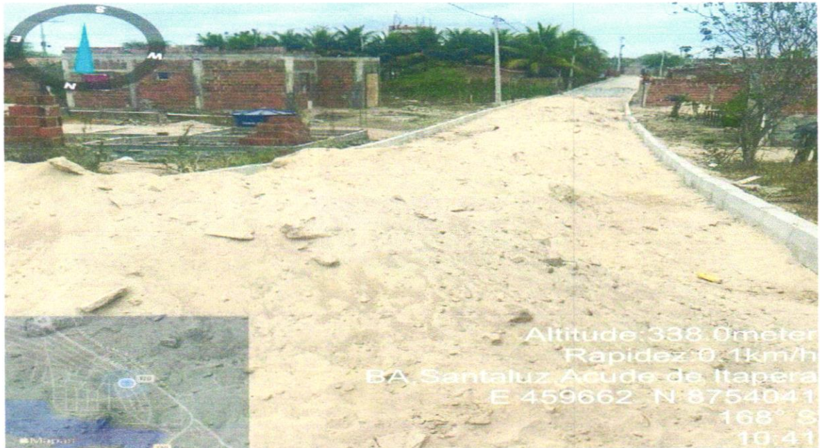
Execução de pavimentação Rua projetada 06
